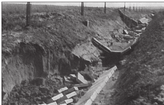
Opevnění koryta odvod. příkopu (svodu) demolované přívalovým deštěm před dokončením stavby (Hodonínsko)
