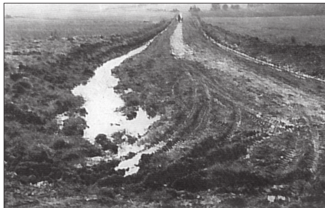
Neudržované staré polní cesty bez příkopů – plní špatnou funkci vodotečí
