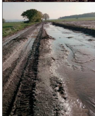
Dopady místní povodně a náhlé erozní události na stavební práce a zemědělskou půdu (str. 11)
