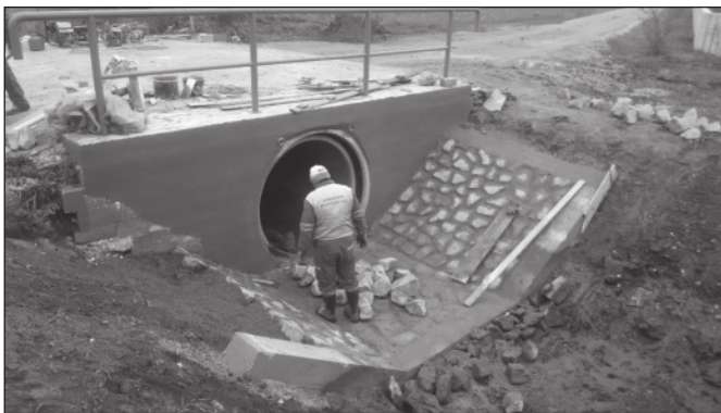
(dlažba do betonu ukončená betonovým prahem)
