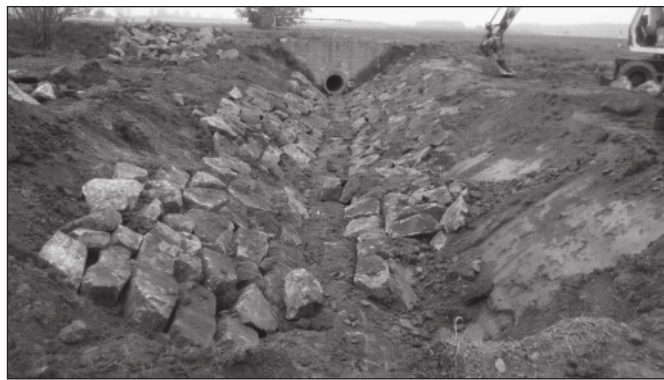
Oprava opevnění HOZ kamennou rovnaninou
