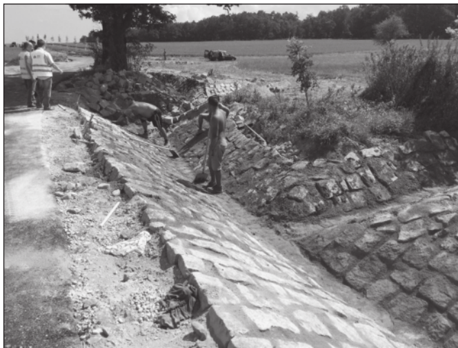
Obrázek 16 Kamenické práce na cestním příkopu, který má funkci bezpečného převedení vody z přívalové srážky v krátkém profilu nad obcí.
