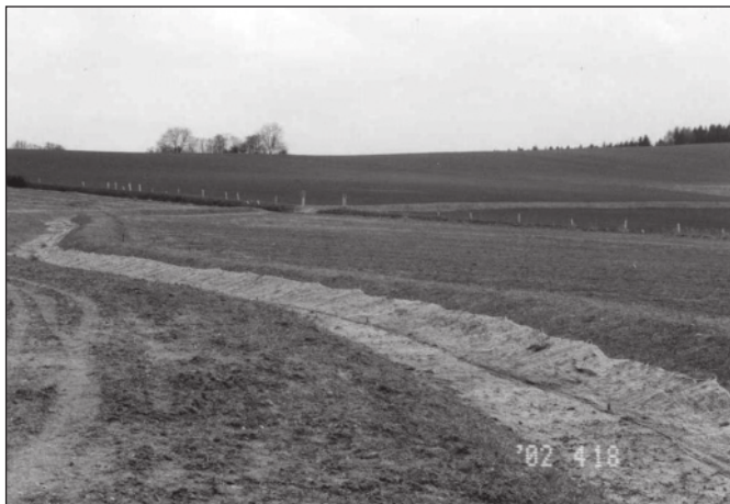
Obrázek 10 Protierozní a protipovodňová mez s průlehem (2002)
