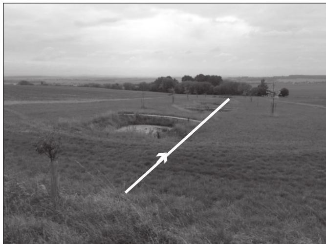
Ukázka výstavby tůň na zakrytém (trubním) kanále v rámci KoPÚ v k.ú. Hněvnice (pobočka Plzeň, se svolením Ing. Mazína)
